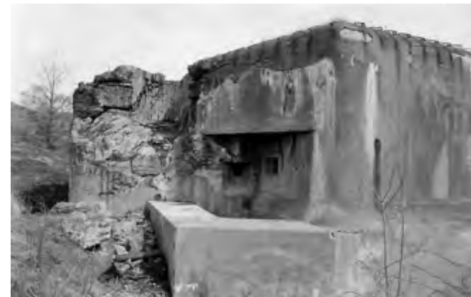
Pěchotní srub MO-S 19 Alej na počátku rekonstrukce
