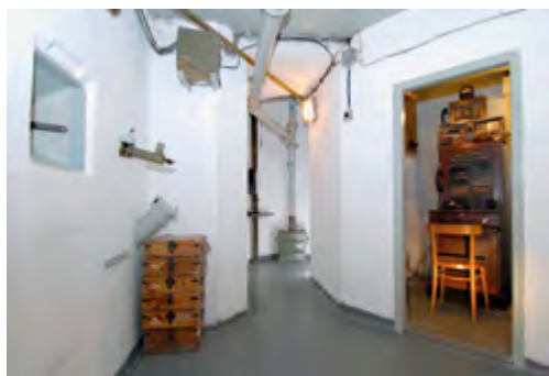
Chodba v levé části objektu
