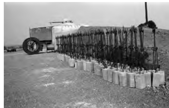
Protipěchotní překážky před Alejí
