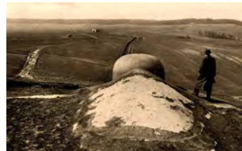
Dobový pohled přes levý zvon MO-S 20 Orel k MO-S 21 Jaroš
