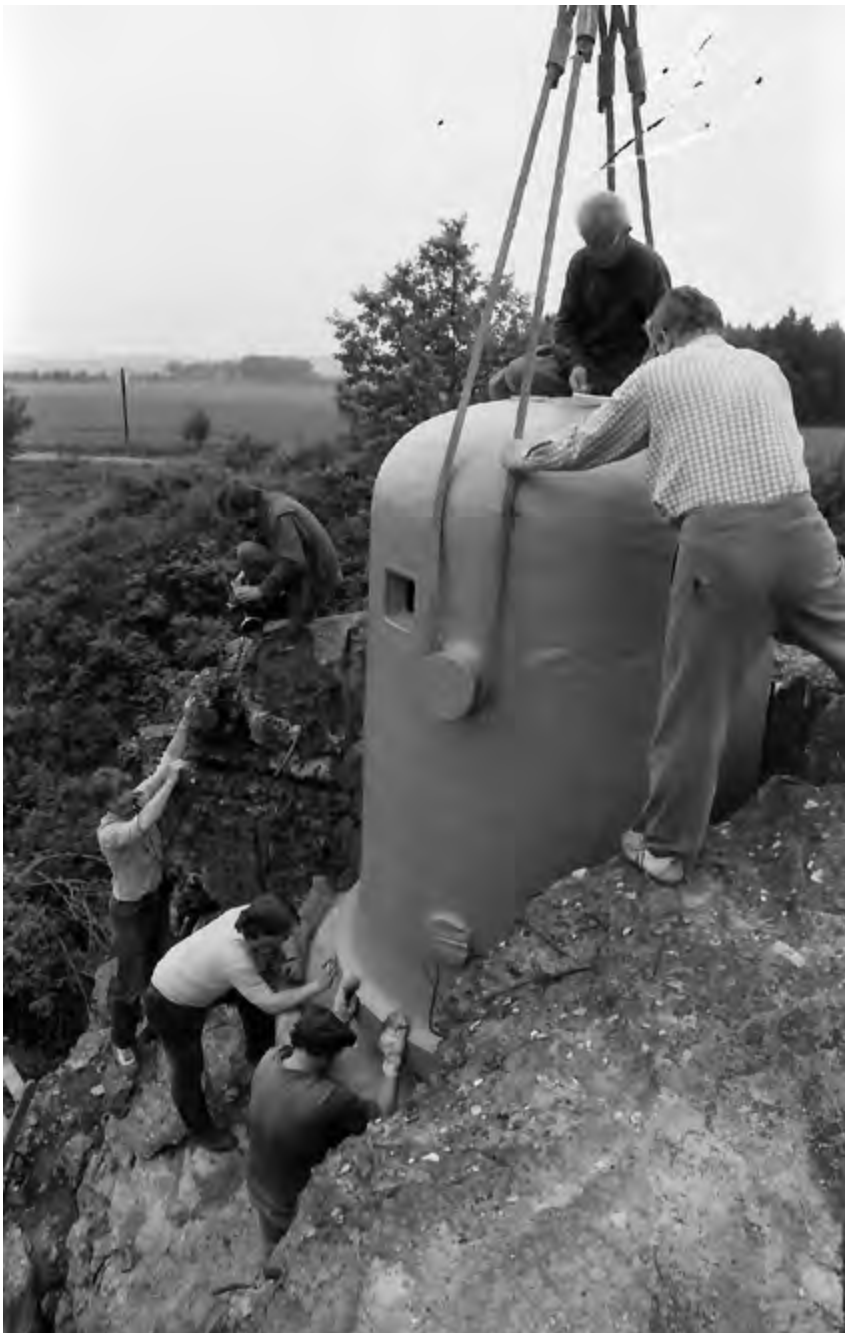
Osazení levého zvonu na MO-S 19 Alej (20. května 1986)
