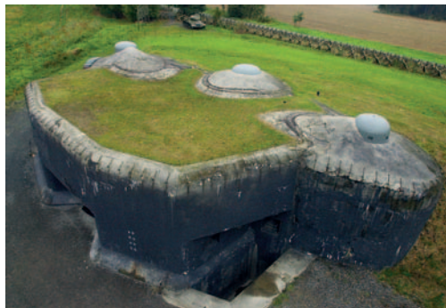
Pohled na zvony a kopuli MO-S 19 Alej (současný stav)
