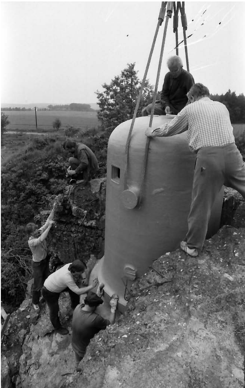
Osazení levého zvonu na MO-S 19 Alej (20. května 1986)
