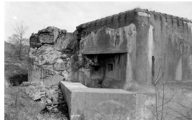
Pěchotní srub MO-S 19 Alej na počátku rekonstrukce
