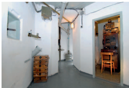
Chodba v levé části objektu
