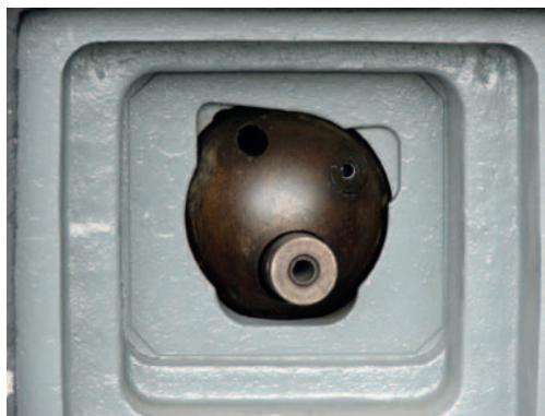
Detail střílny s těsnící koulí
