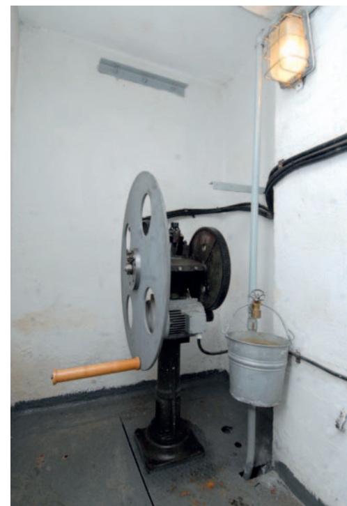
Čerpadlo Royal o výkonu 21 litrů za minutu, dokáže čerpat vodu až z hloubky 150 metrů
