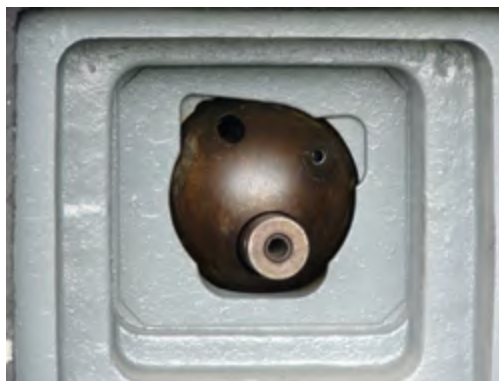
Szczegół strzelniczy z kulą uszczelniającą
