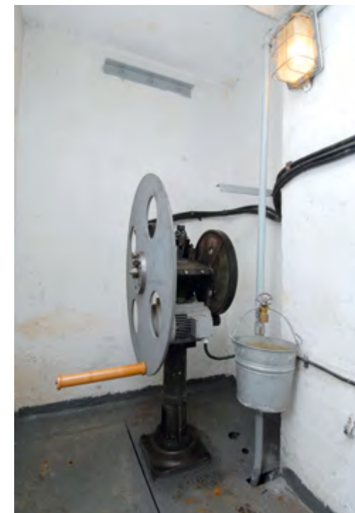
Pompa Royal o wydajności 21 litrów na minutę, potrafi pompować wodę z głębokości do 150 metrów
