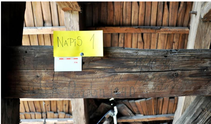
9. Ukázka nápisů na trámu v krovu nad presbytářem (foto J. Koudelová 2011)
