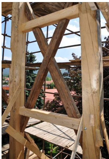
7. Příklad výměn a zachování starých dřevěných prvků v konstrukci věže kostela sv. Ondřeje. Použití moderních svorníků při zajištění spojů bylo pouze dočasné, v konečné fázi stavebních prací byly nahrazeny dřevěnými kolíky (foto J. Koudelová 2011)
