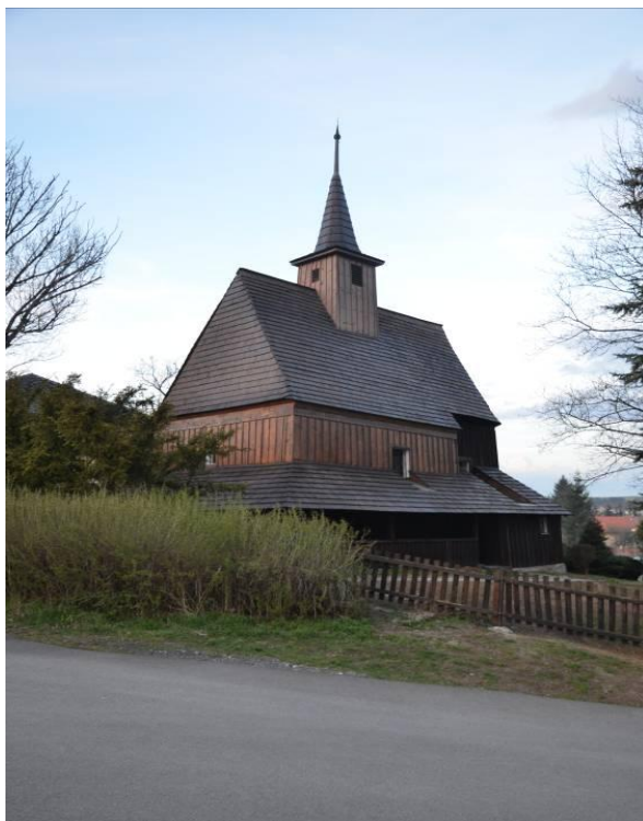
12. Celkový pohled na kostel sv. Ondřeje z jihozápadu po rekonstrukci (foto J. Koudelová 2012)
