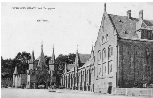
1. Pohled na areál Červeného zámku od severu – původní řešení východní a severní fasády, střechy provozní věže, východní fasády a střechy východního křídla, 1910. (SZMO, fotoarchív, sig. FP 6363/1)
