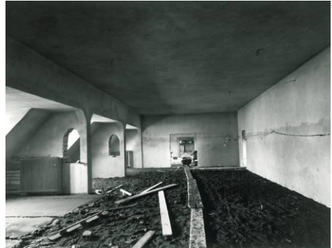
8. Adaptace 3. NP východního křídla – výstavba kluboven, foto Josef Solnický, 1959. (SZMO, fotoarchív, sig. B 7.369)
