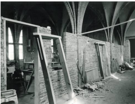
7. Adaptace 1. NP východního křídla – zřízení spojovací chodby z haly k jídelně, foto Josef Solnický, 1959. (SZMO, fotoarchív, sig. B 7.366)
