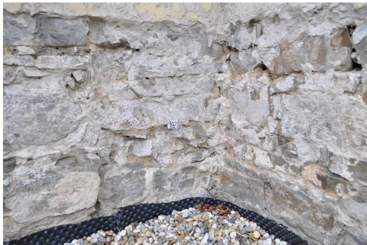
19. Lubojaty, kostel sv. Jiří, kout mezi západní zdí lodi a jižním bokem věže s patrným provázáním zdiva obou částí, vlevo viditelná spára druhotného zaslepení původního jižního průchodu do podvěží, stav v roce 2010 (foto: Radek Kadlubiec)
