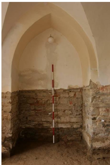
9. Lubojaty, kostel sv. Jiří, podvěží s druhotně zazděným průchodem v severní zdi věže, pohled k severu, stav v roce 2010 (foto: František Kolář)
