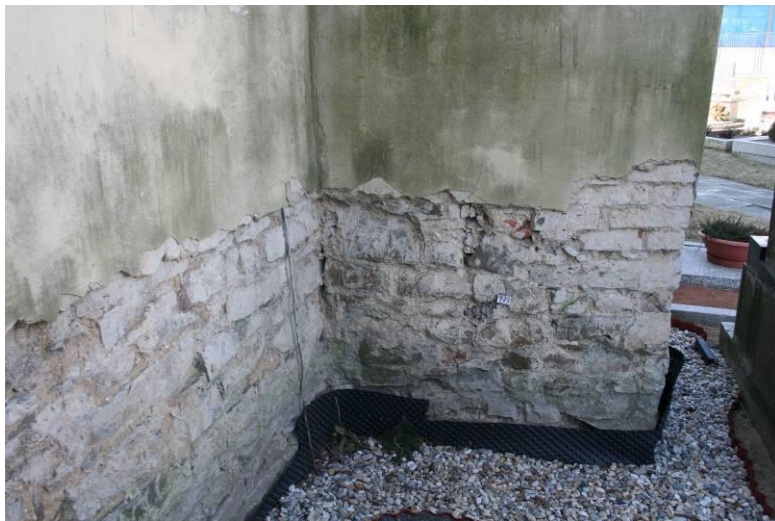
16. Lubojaty, kostel sv. Jiří, severní opěrák lodi s patrným dodatečným zesílením, stav v roce 2010 (foto: Andrea Kožuszníková)
