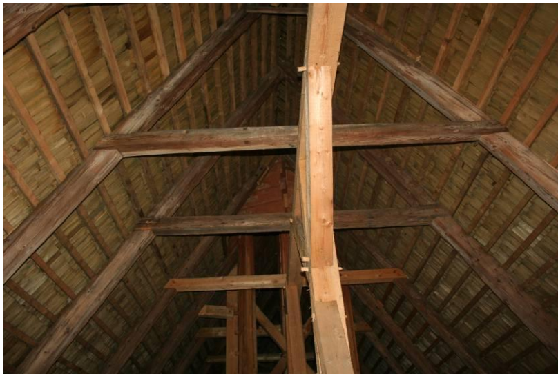
22. Lubojaty, kostel sv. Jiří, průhled rekonstruovaným krovem lodi k východu, v pozadí patrná vetknutá konstrukce sanktusní věže, stav v roce 2010 (foto: Andrea Kožuszniková)
