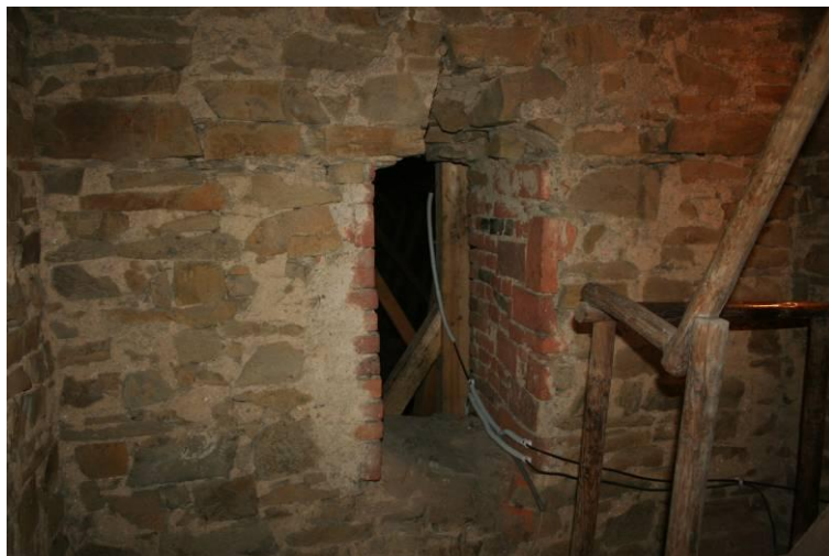
23. Lubojaty, kostel sv. Jiří, východní zed' věže s druhotně proraženým průchodem z druhého věžního patra do podkroví lodi, pohled od západu, stav v roce 2010 (foto: Andrea Kožuszniková)
