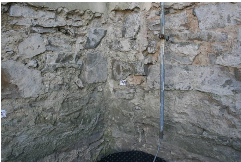
17. Lubojaty, kostel sv. Jiří, kout mezi západní zdí sakristie a severní stranou lodi s patrnou spárou oddělující přístavbu mladší, renesanční lodi od gotického presbytáře, stav v roce 2010 (foto: Andrea Kožuszniková)
