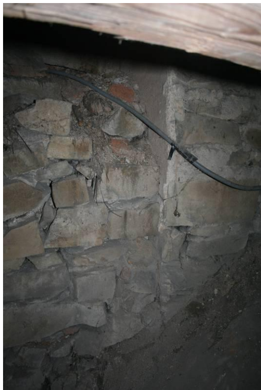
20. Lubojaty, kostel sv. Jiří, jihovýchodní nároží věže v podkroví spatrnou dodatečnou přízdívkou spodní části západního štítu lodí ke starší omítnuté části věže, stav v roce 2010 (foto: Andrea Kožuszníková)
