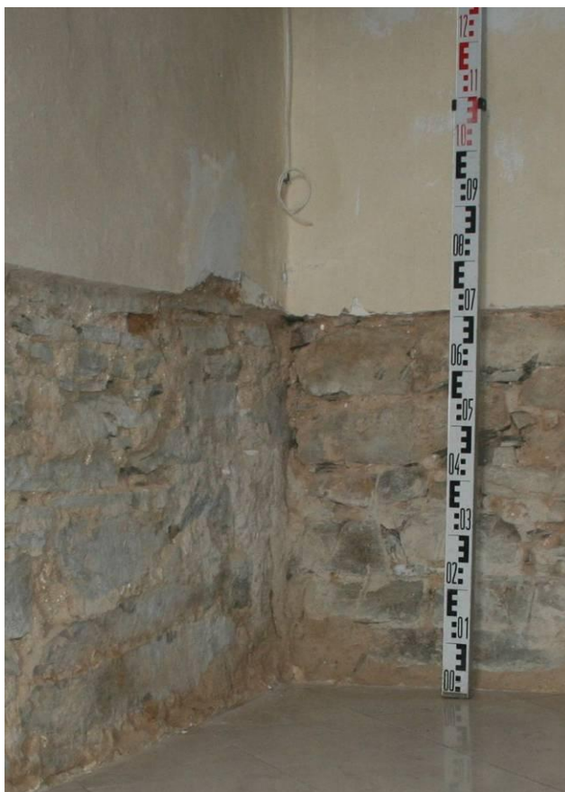
18. Lubojaty, kostel sv. Jiří, jihovýchodní kout lodi s patrnou spárou oddělující renesanční přístavbu lodi od starší gotické východní zdi s vítězným obloukem, stav v roce 2010 (foto: Andrea Kožuszniková)
