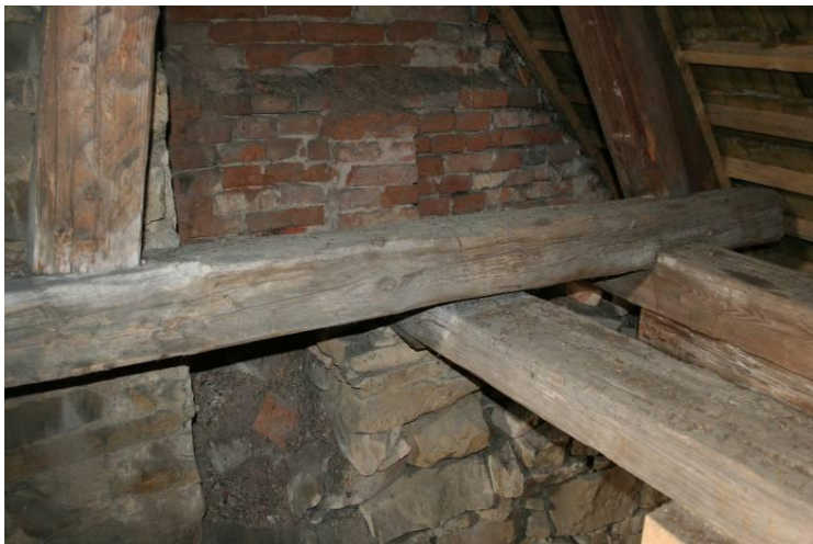
21. Lubojaty, kostel sv. Jiří, severovýchodní nároží věže v podkroví s patrným torzem ostění původního přístupu do podkroví vedle tělesa věže, později zaslepeného v souvislosti s výstavbou cihelného západního štítu loďi, stav v roce 2010 (foto: Andrea Kožuszniková)
