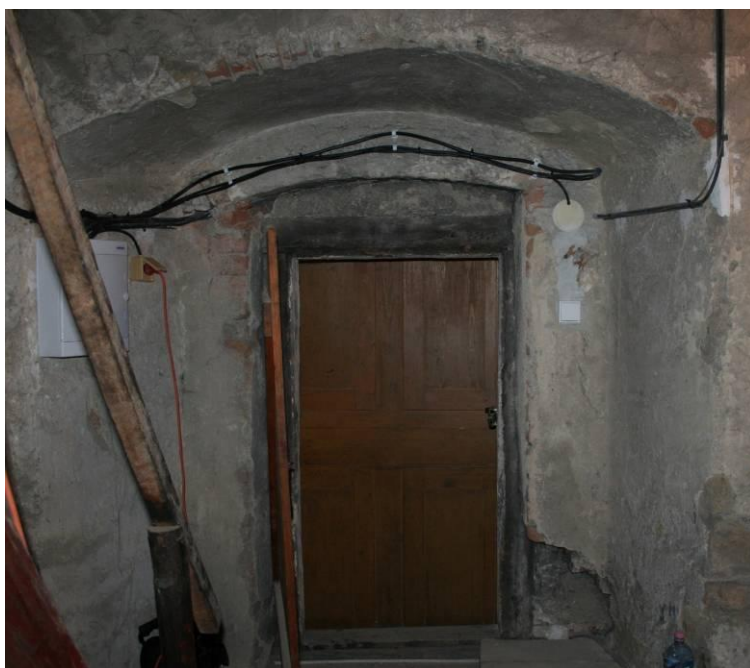
10. Lubojaty, kostel sv. Jiří, první patro věže, pohled k východu na vstup z kruchty do věže, stav v roce 2010 (foto: Andrea Kožuszníková)
