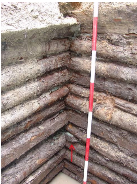
6. Jívová – Tepenec, detailní pohled na východní roh roubené konstrukce. Ve spodní části JV stěny je patrný vložený kámen umožňující snadnější přítok vody (foto V. Vránová)
