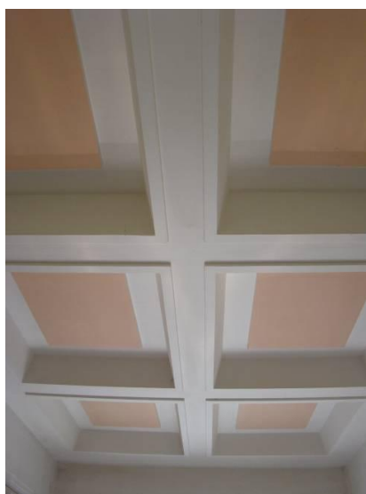
8. Kasetový strop vstupní předsíně, foto A. Hubáček
