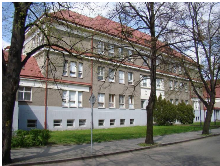
5. Současná podoba budovy hlučinského gymnázia po stavebních úpravách z roku 1976, foto Adam Hubáček
