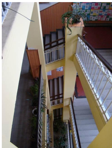
9. Schodiště hlučinského gymnázia, foto A. Hubáček
