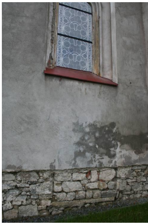
6. Zazdívka původního vstupu z odbourané severní sakristie do presbytáře a okno v severní stěně presbytáře, nově prolomené mezi lety 1902–1914 (foto Andrea Kožuszniková, 2013)
