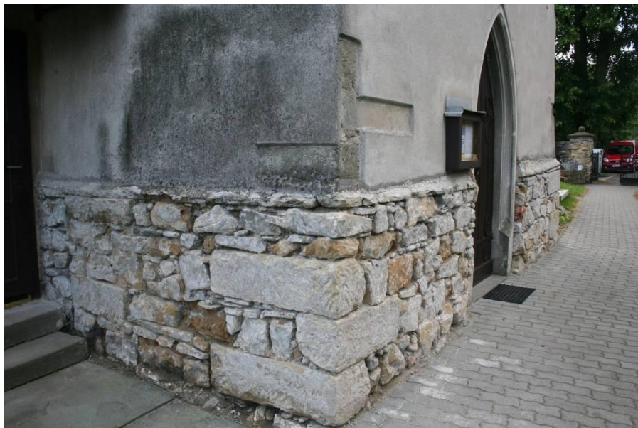
8. Kamenný sokl věže s patrnou zazdívkou původního vstupu v severní stěně (foto Andrea Kožuszniková, 2013)
