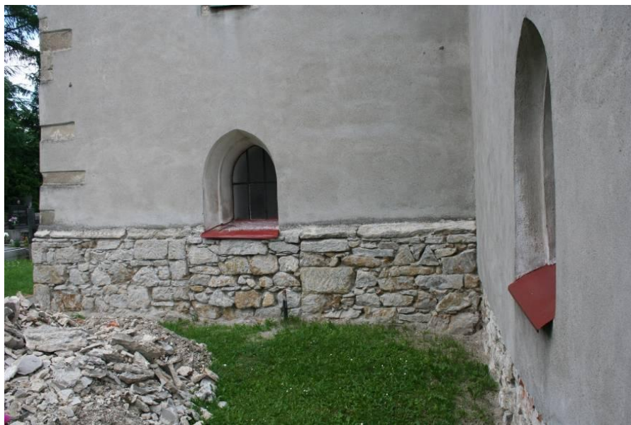
9. Zazdívka původního vstupu v jižní stěně věže s dodatečně vloženým hrotitým oknem (foto Andrea Kožuszniková, 2013)
