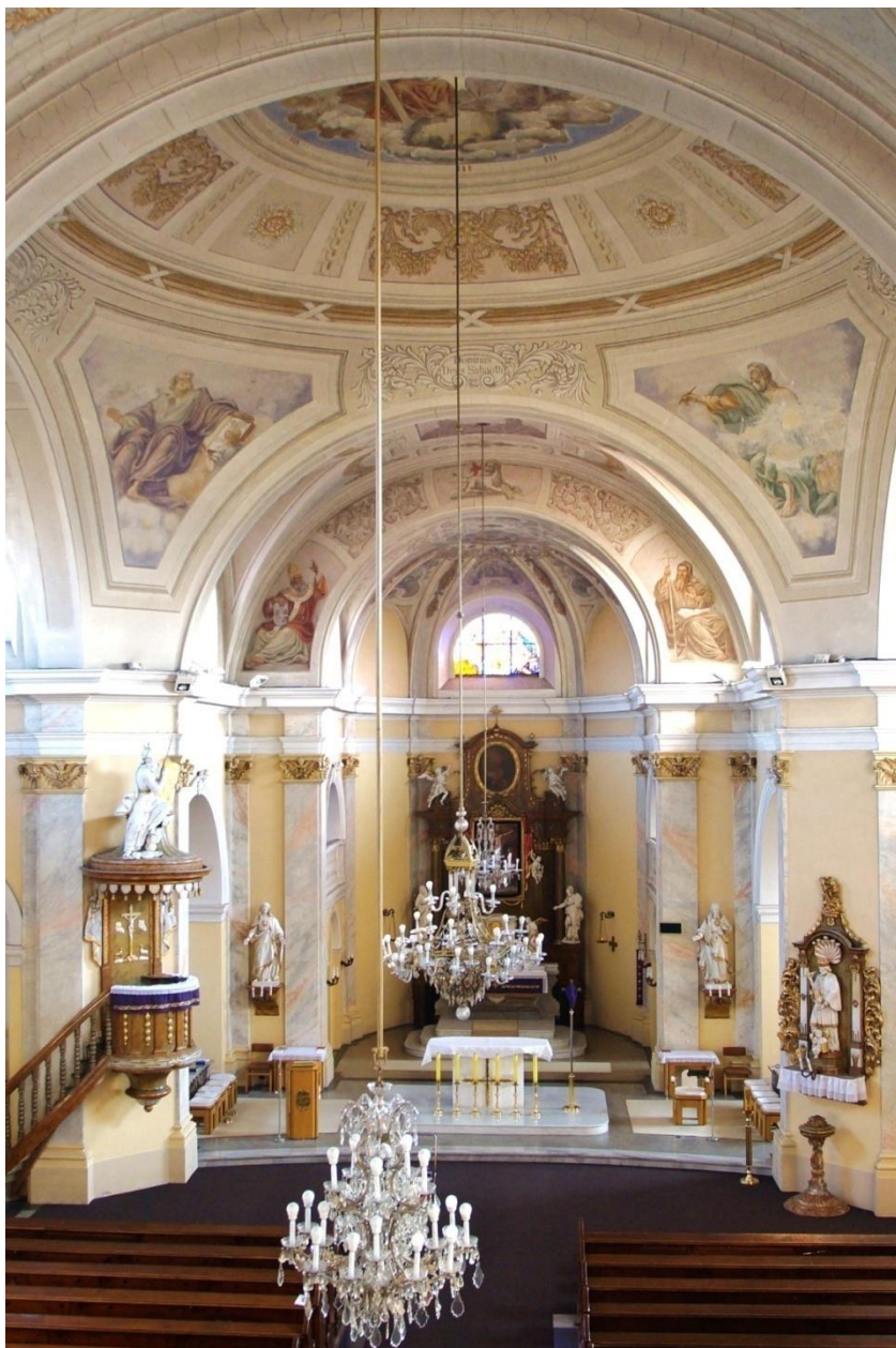
9. Interiér kostela sv. Stanislava v Bolaticích. Foto Adam Hubáček, 2015
