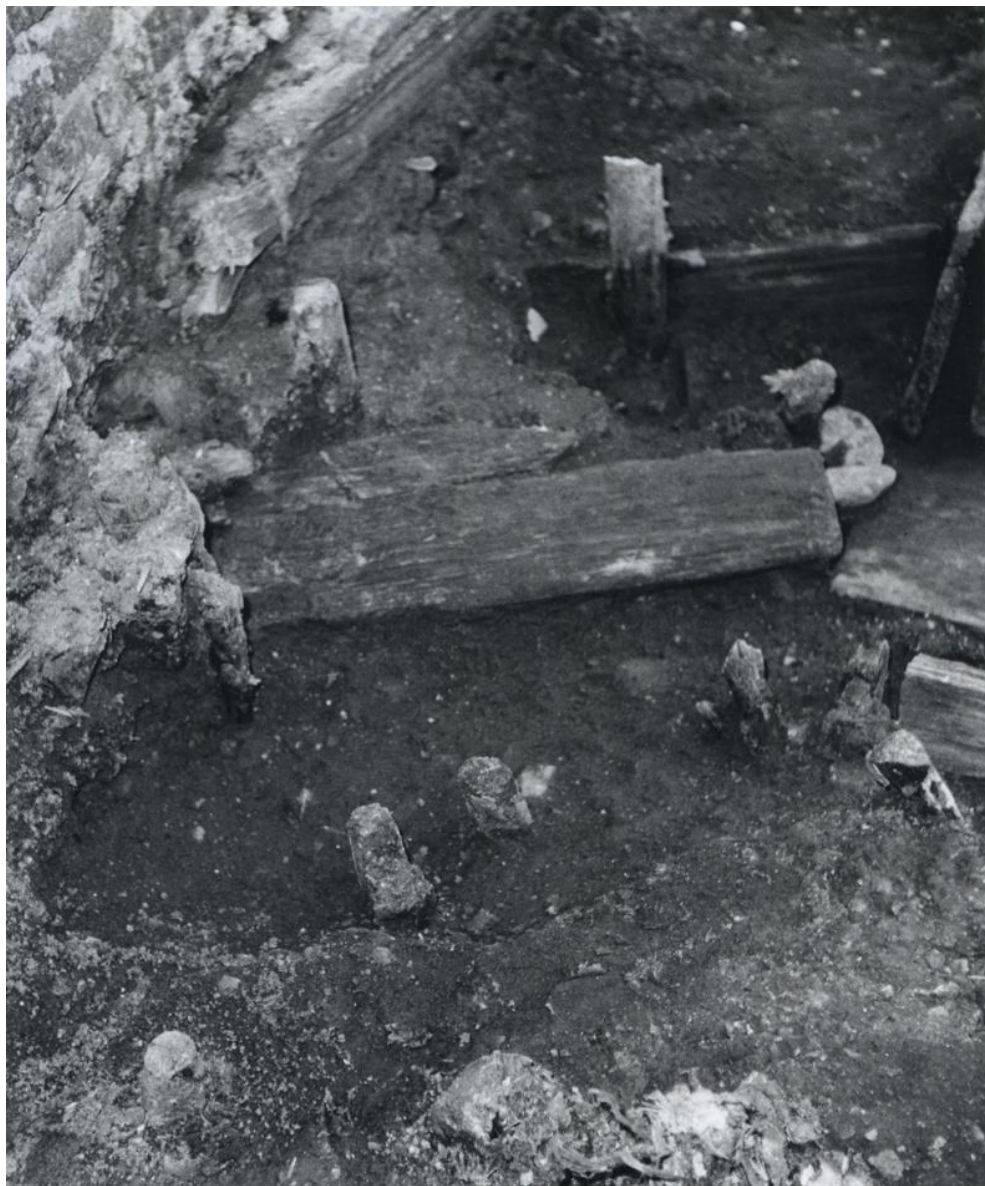
5. Opava – dominikánský klášter, detail prostoru před vstupem od S – „šije“ z prken kotvených kolíky, foto: A. Pustka, 12.1967, archiv fotografického pracoviště SZM, inv. č. B 68.310
