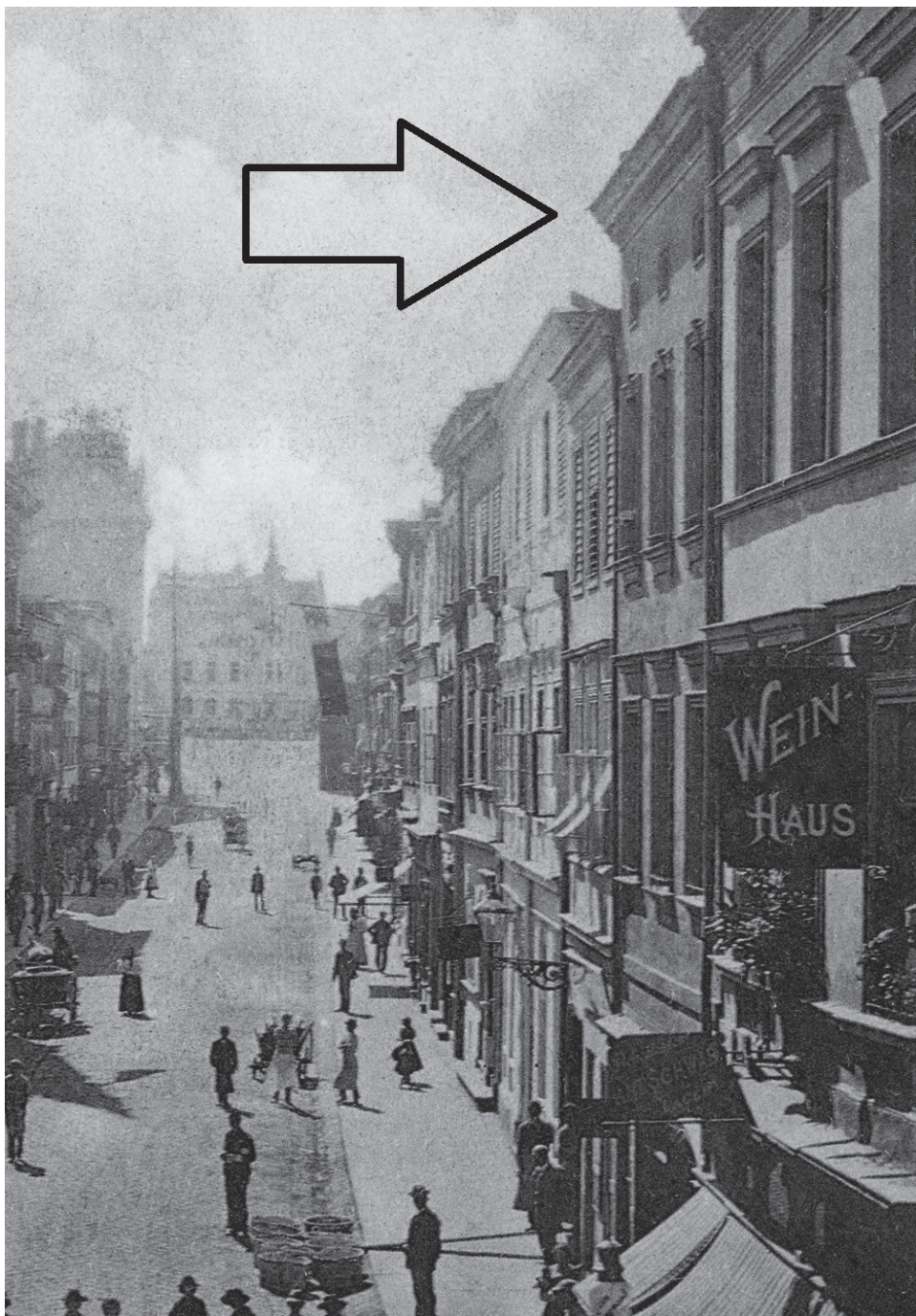
Obr. 4: Průčelní fasáda domu čp. 210 v Opavě, výřez, druhý dům zprava, značeno šipkou, 1898. SZM, fotopracoviště, inv. č. FP10128/2.
