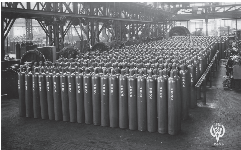
Obr. 4: Zakázka tisíce lahví o objemu 46,7 l pro Japonsko přes firmu Illies & Co. AV, fond VHHT-foto, kart. 9, inv. č. 200.
