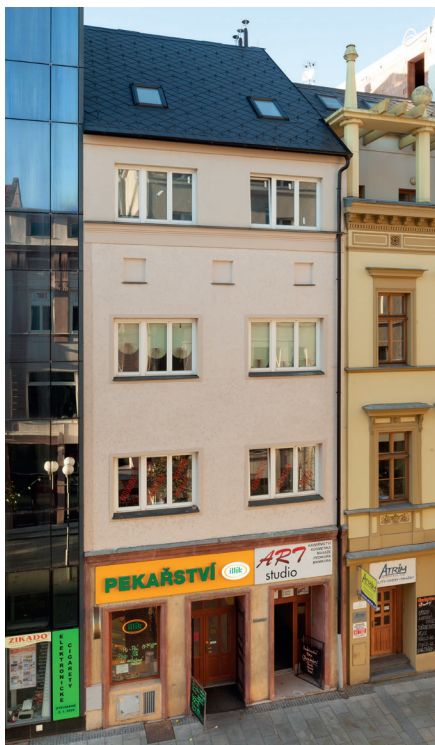
Obr. 1: Současný stav hlavního průčelí domu čp. 210 (Ostrožná 8) v Opavě, 2020.
