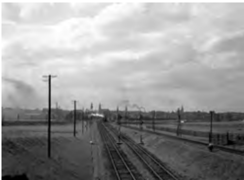
• Železniční trať ve směru od Ostravy do Opavy. 30. léta 20. století
