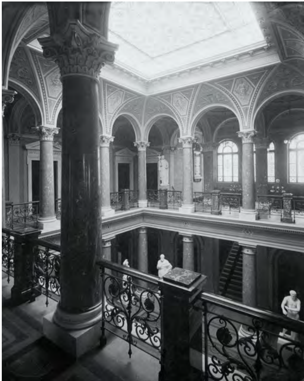
• Interiér Historické výstavní budovy z roku 1895
