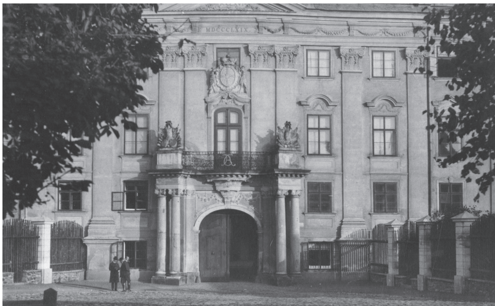
Obr. 2: Bruntál, vstup do zámku, poč. 20. stol. SZM, ev. č. 82.2710.
