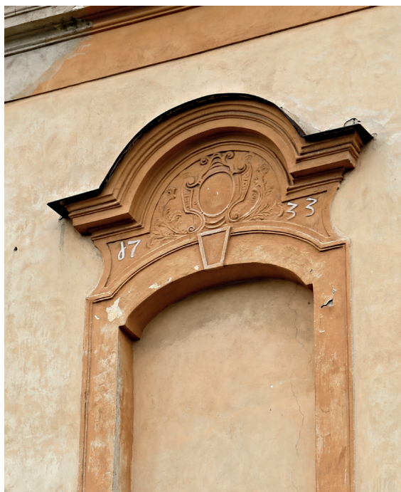
Obr. 8: Třemešná, kostel sv. Šebestiána, dekorace suprafenestry slepého východního okna presbytáře s datem dokončení stavby. Foto Dalibor Prix, 2020.
