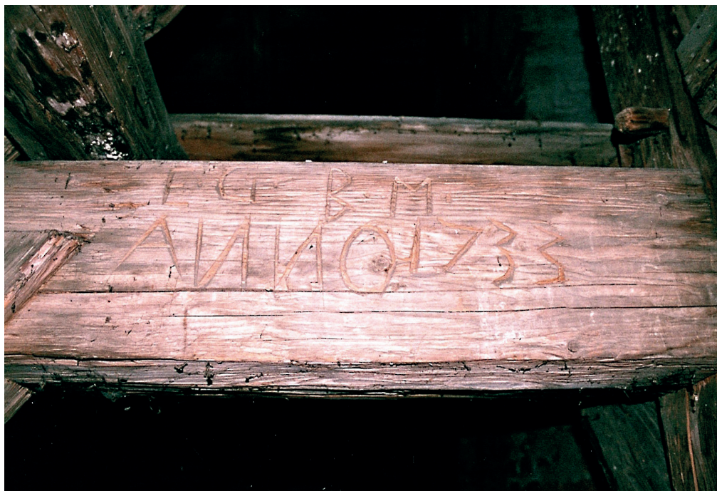
Obr. 2: Třemešná, kostel sv. Šebestiána, krov presbytáře, signatura Eliase Grosse a datace na středové vaznici.
