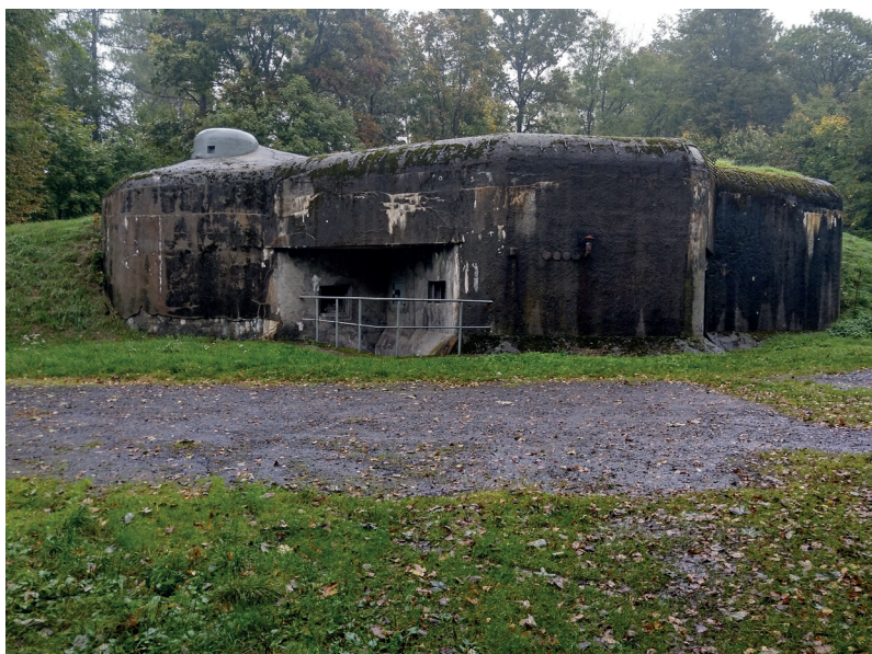
Obr. 2: Pěchotní srub MO-S 19 Alej v katastru obce Hlučín-Darkovičky, ve správě SZM. Foto: Autor.
