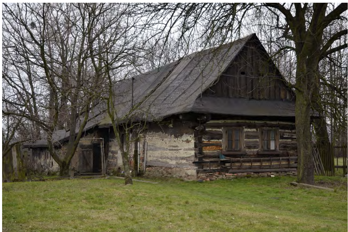
Pohled na roubený Dům u č. p. 416 v Ostravě-Bartovicích. Foto: O.Schejbal
