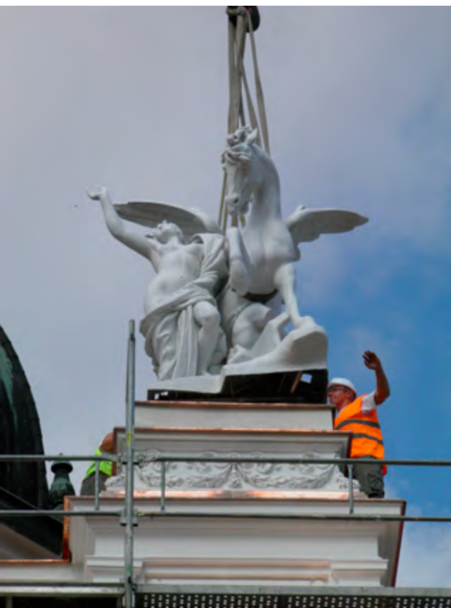
Instalace sousoší Pegasů. Foto: B. Honková.
