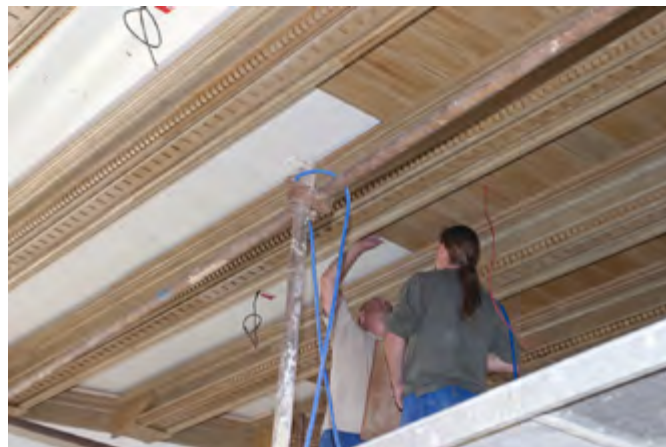
Instalace restaurovaného dřevěného stropu. Foto: Archiv SZM.
