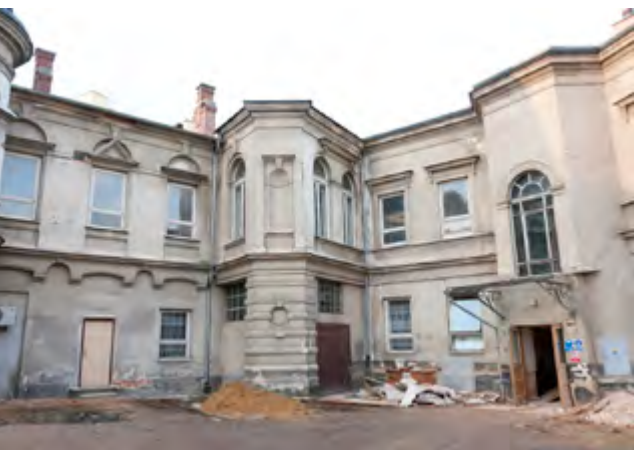
Nádvoří knihovny před rekonstrukcí. Foto: Archiv SZM.
